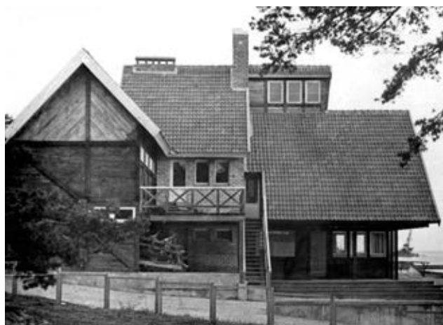
Sporto mokyklos pastatas iki rekonstrukcijos
