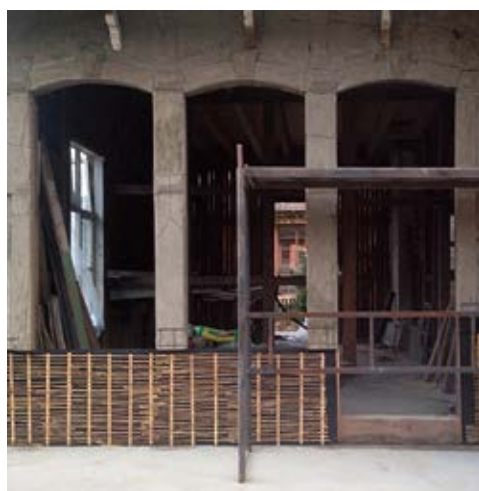
Geriausiai tinkas išsilaikė ant sienos, kurią gaubė ir nuo drėgmės saugojo veranda. Restauruojant šioje vietoje pavyko palikti autentišką tinką.
